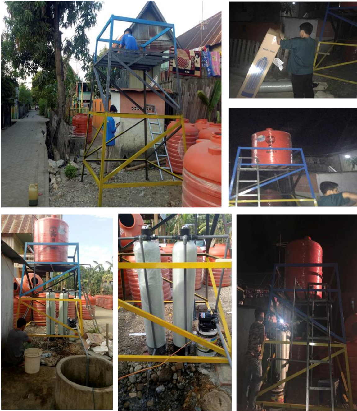
Gambar 2. Pemasangan Instalasi Air Bersih kepada warga Dusun Biringkassi Desa Bulu Cindea Kecamatan Bungoro Kabupaten Pangkep
