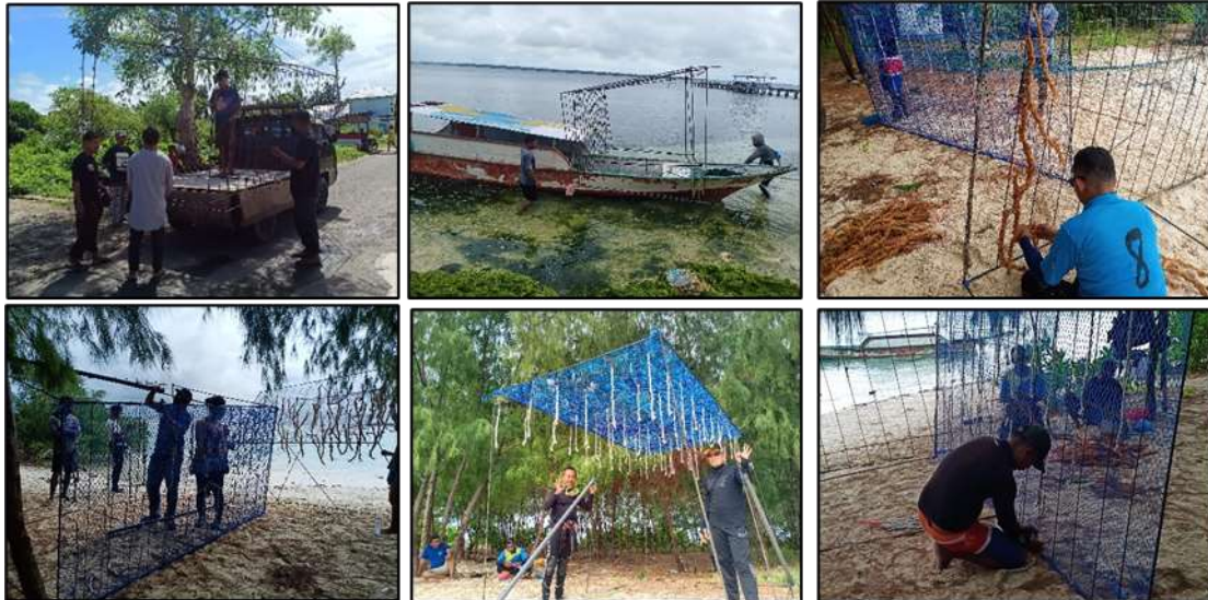
Gambar 1. Proses pengangkutan Rangka Rumpon Hybrid ke Pulau Adranan kemudian dilanjutkan dengan melakukan perakitan
